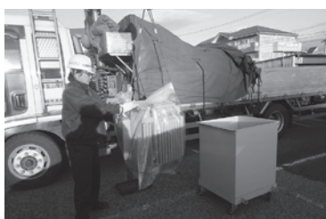
トランス等の処分の様子
