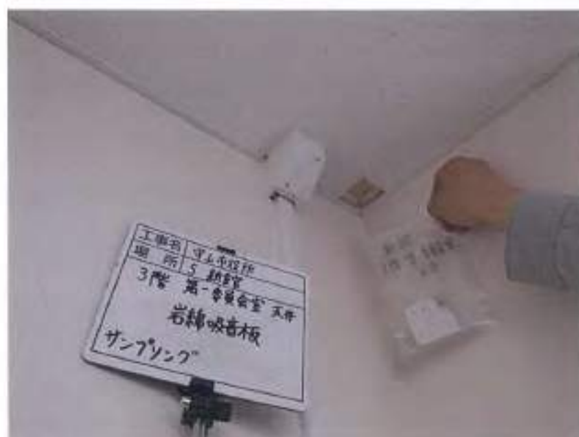
守山市役所新庁舎 基本設計業務における 石綿事前調査
