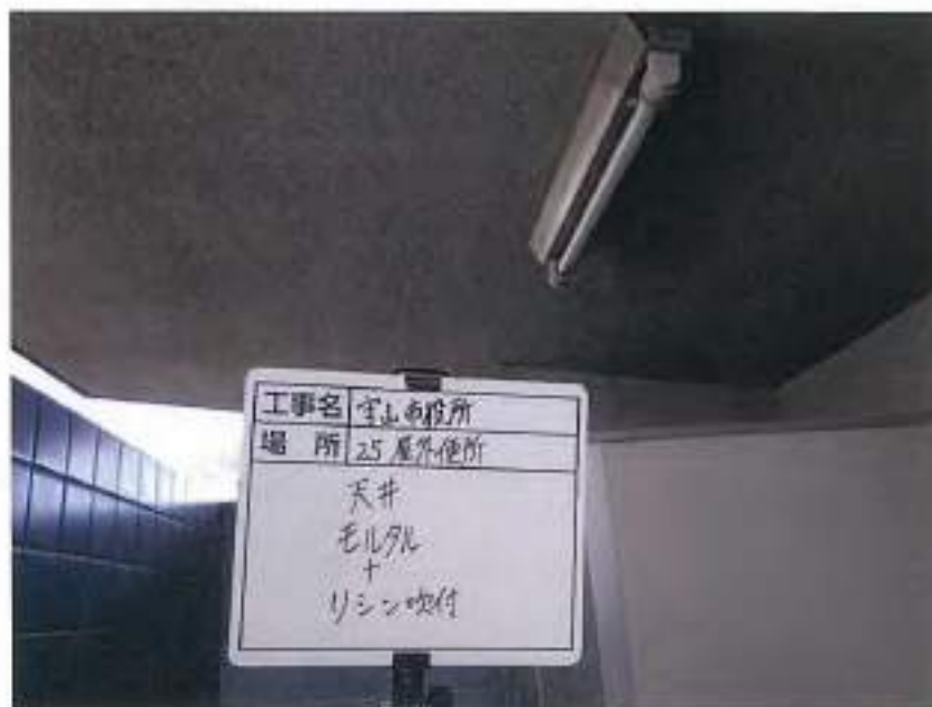
守山市役所新庁舎 基本設計業務における 石綿事前調査
