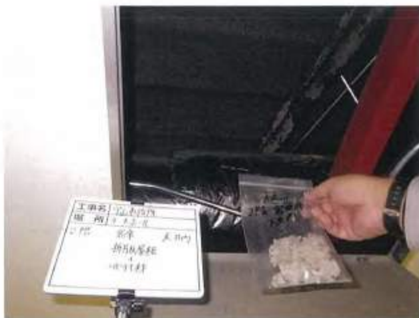
守山市役所新庁舎 基本設計業務における 石綿事前調査
