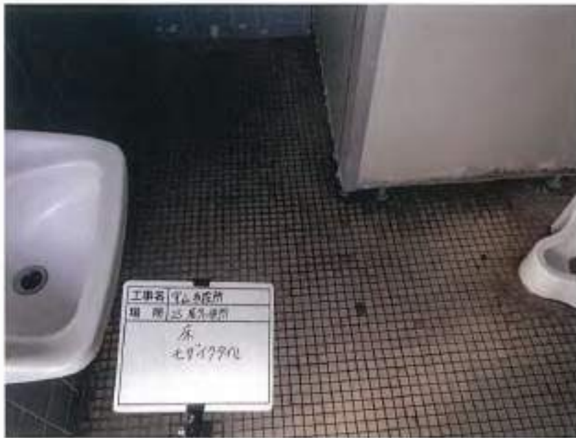
守山市役所新庁舎 基本設計業務における 石綿事前調査
