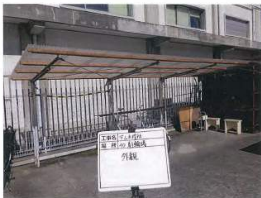
守山市役所新庁舎 基本設計業務における 石綿事前調査
