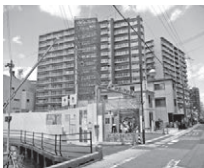
ほたる通りのマンション建設の様子
