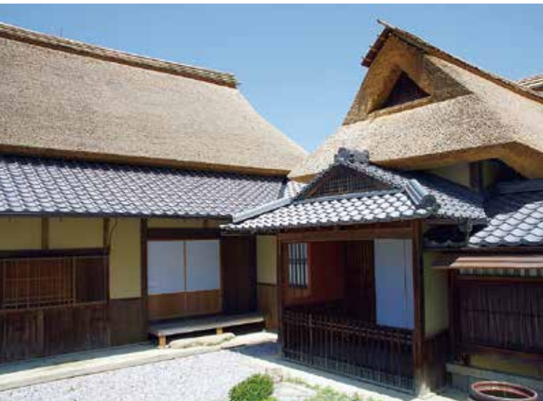
▲大庄屋諏訪家屋敷主屋と書院
