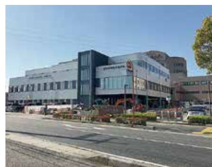
▲新館建設中の済生会守山市民病院
