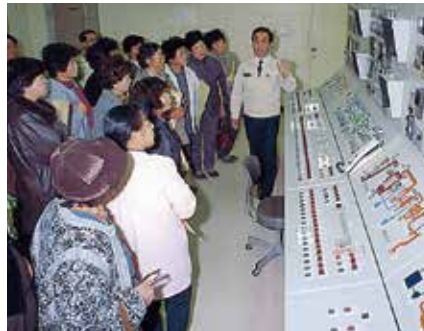
▲守山市環境センター指令室内部 [1985(昭和60)年]
