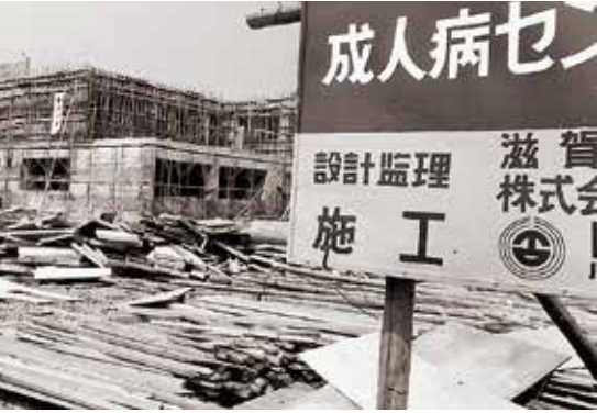
▲成人病センターの工事進む
