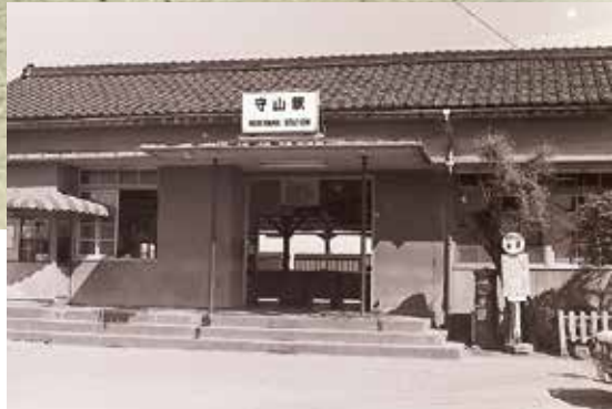
▲物部村勝部に開業した旧守山駅舎 [1912(明治45)年]
