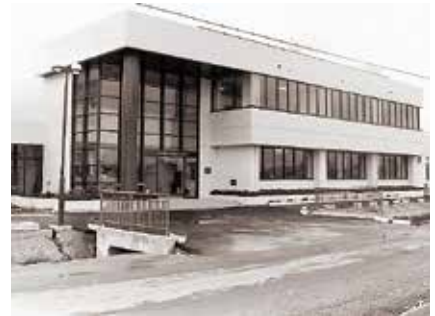
▲新設当時の地域総合センター
