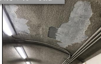
吹付け材の剥離
