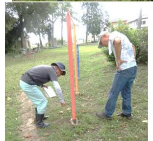
小公園および緑地の遊具等の安全点検を市からの調査票に基づき実施しました。町内にある6カ所のブランコ、鉄棒、滑り台、シーソーを対象に具体的にハンマーで打検、目視、滑り台の裏面の腐食状態、公園内のフェンスの破れ等を確認しました。至急に安全点検の結果を集約し、市へ改修事項を報告するとともに対応を要望します。
