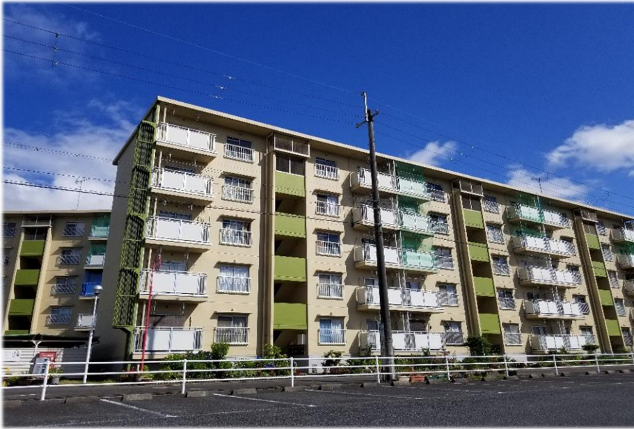
大門団地 参考写真（※住戸内の状況は一例です。）
