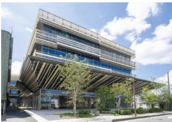
省CO 2 技術の導入によりZEB Readyを達成した新庁舎
