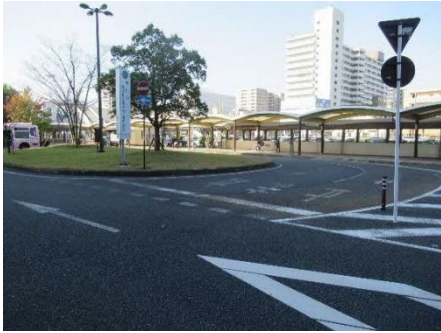
①ロータリー出口付近
