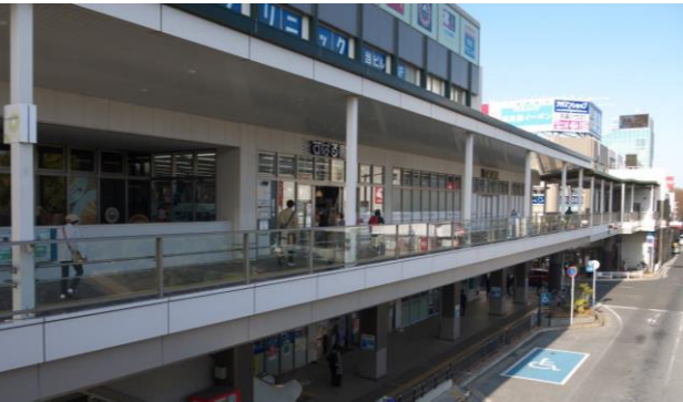
■ロータリー北側の北習志野駅前ビルに直結
