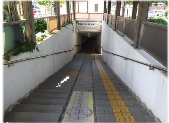
■地下道(階段部分)
