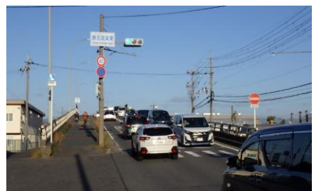
■高架橋(県道片岡栗東線)
