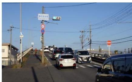
■朝の高架橋(県道片岡栗東線)の様子
