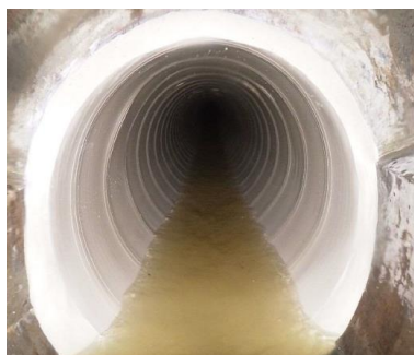
耐震性を有する管渠の更生
