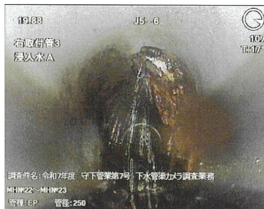
テレビカメラによる下水管渠調査
