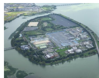
【湖南中部浄化センター】
