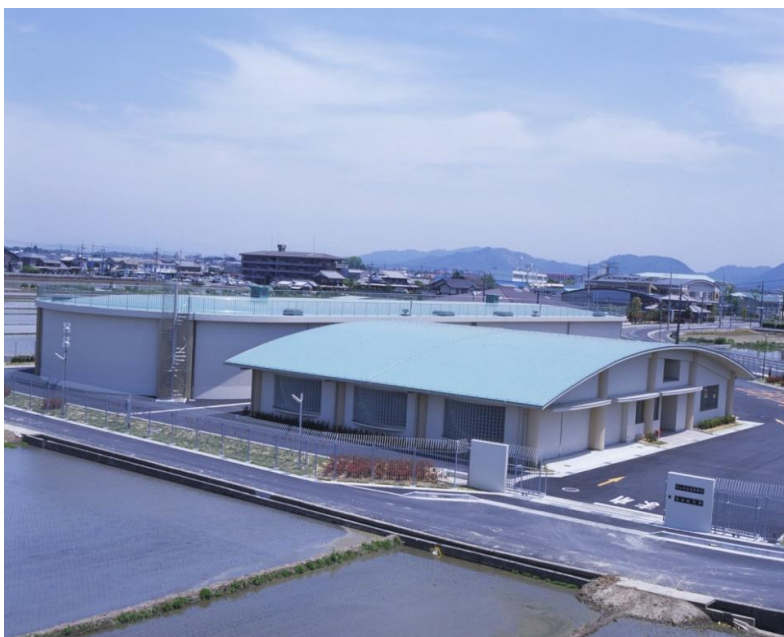
石田配水場全景 (西方向より撮影)
