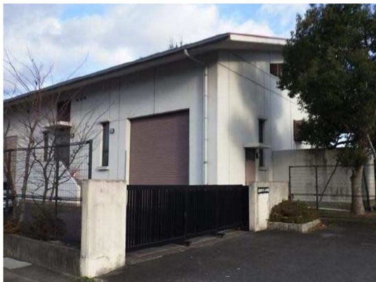
速野ポンプ場
