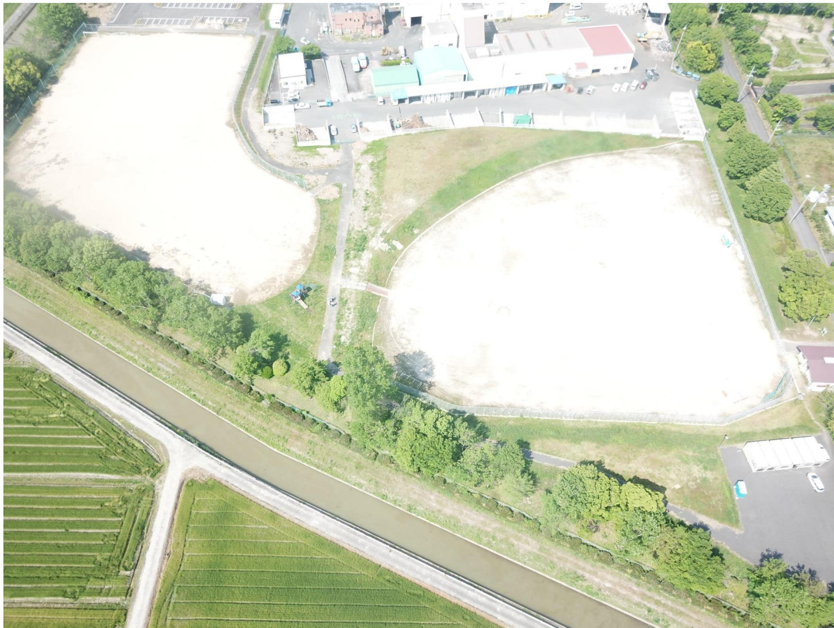
令和元年5月（2019年5月）の状況 【工事前】
