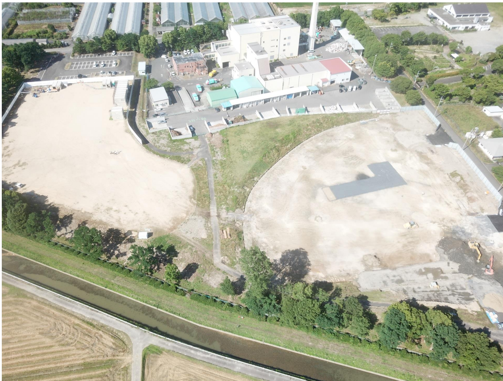
令和元年6月（2019年6月）の工事状況 6月17日撮影
