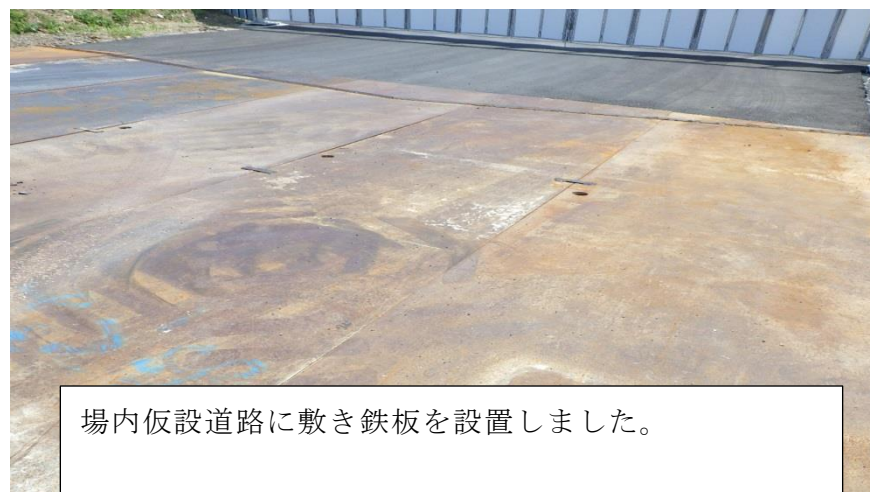
(4) 敷き鉄板の設置
