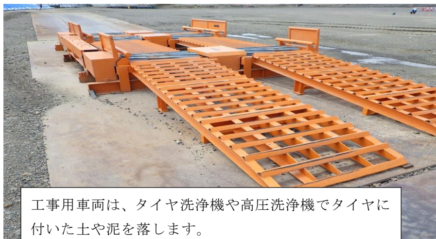
(3) タイヤ洗浄機の設置
