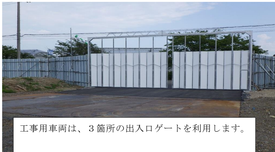
(1) 工事用車両が出入りするゲートの設置
