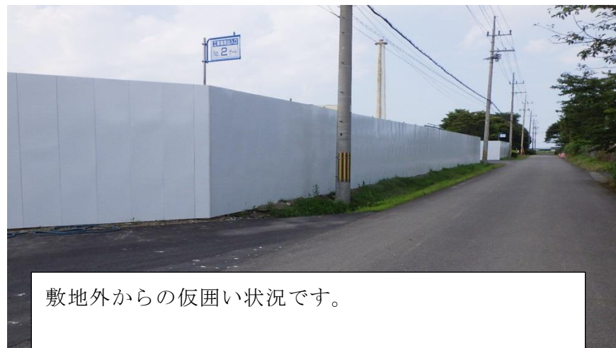
(2) 仮囲いの設置
