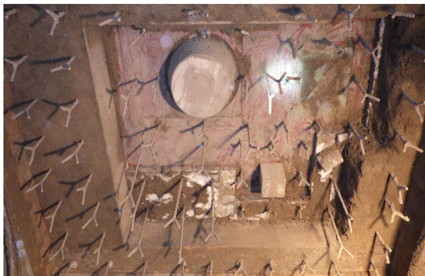
(3) 熱回収施設：焼却炉内耐火物施工
