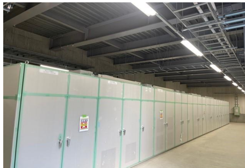
(4) 熱回収施設：高圧電気盤据付
