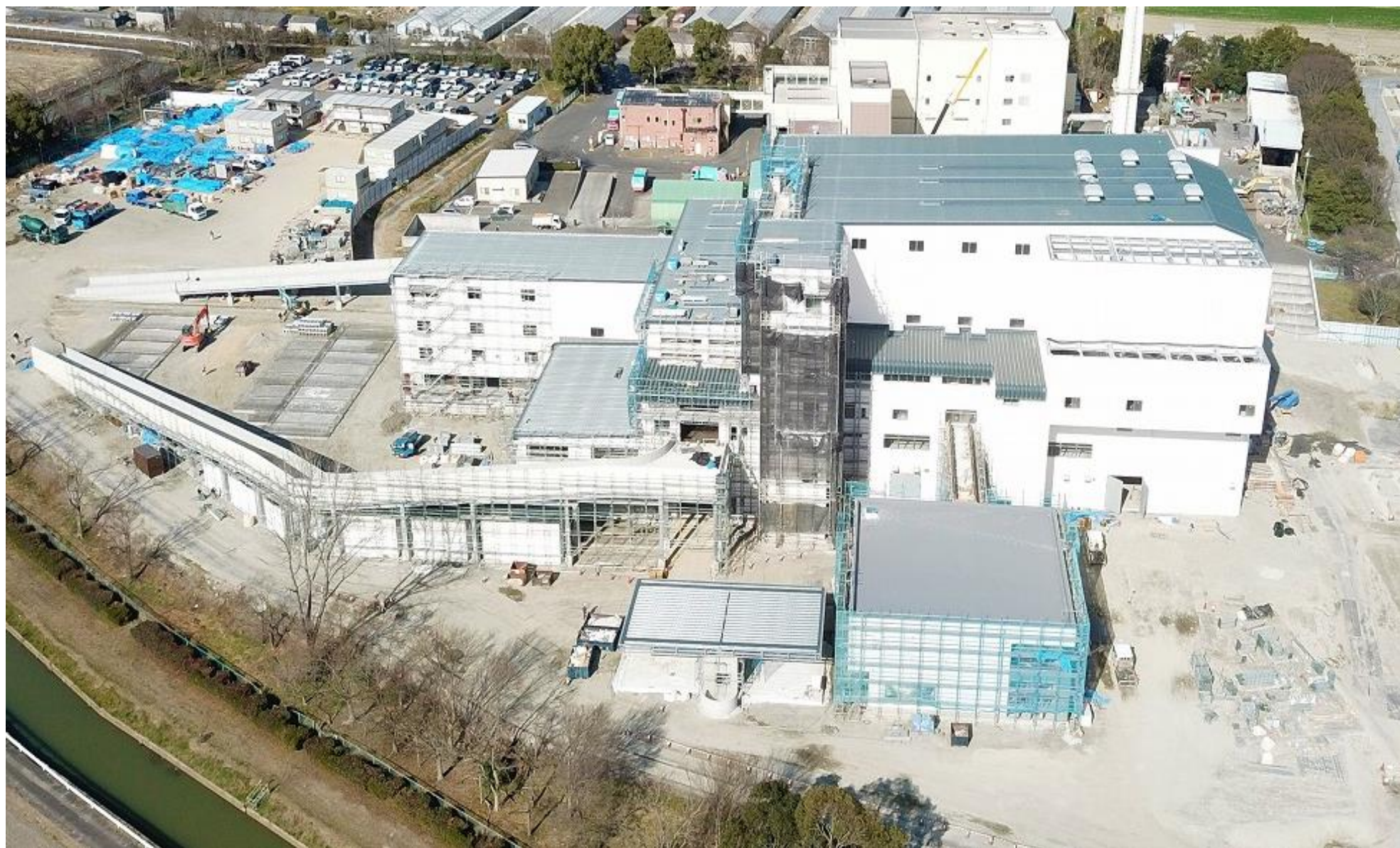
令和3年2月（2021年2月）の工事状況 2月25日撮影
